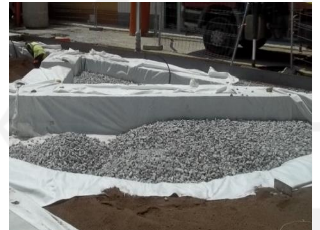
I-DIP Bon Pastor (dipòsit grava en construcció)
